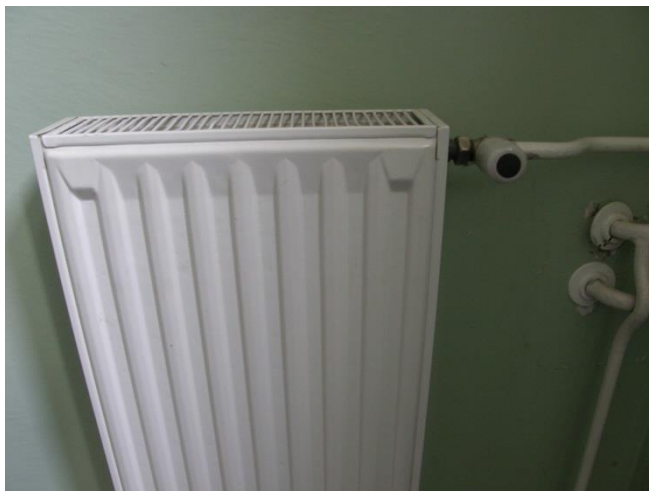
Slika 4. Ventil pred zamenjavo
