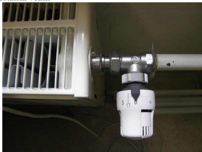
Slika 3. NOV termostatski ventil
